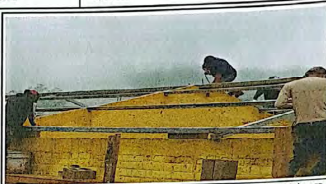
Foto 2: Cambio de vigas de madera por tubos y costaneras de metal para darle mas firmeza a las laminas y así evitar filtraciones de agua.
