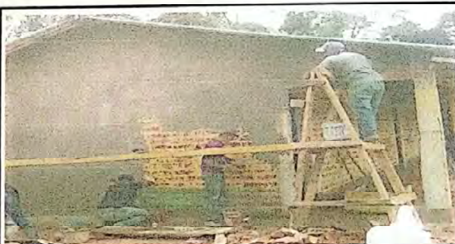
Foto 6: Repello de paredes agrietadas para que tenga mas durabilidad la infraestructura.
