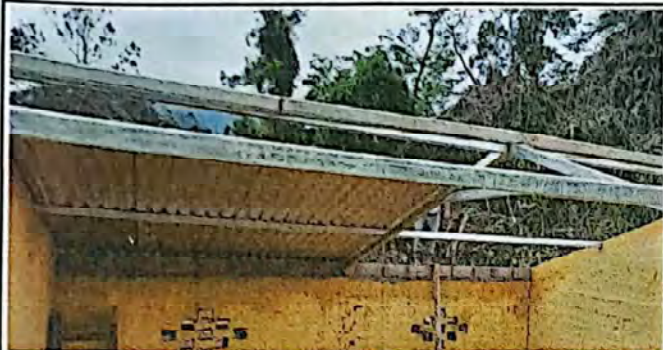
Foto 1: Cambio de laminas que cubren la escuela, para evitar el deterioro de la infraestructura.
