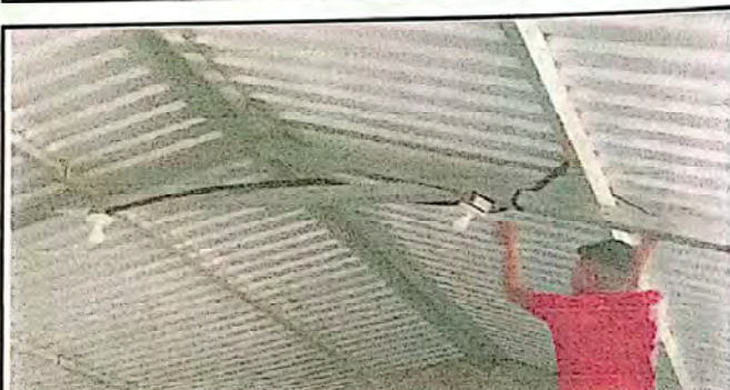
Foto 4: Reparacion de cableados electrico para que halla mejor claridad en las aulas.
